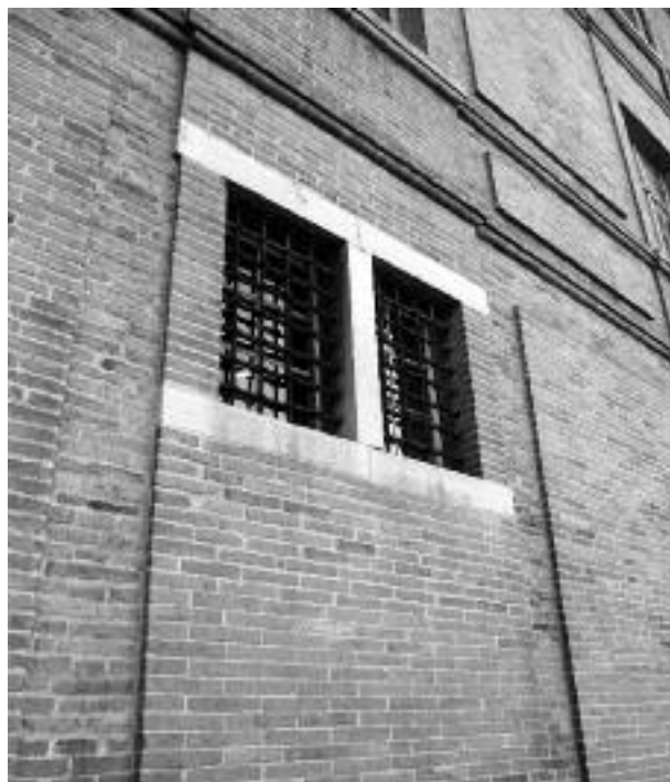
Fig. 26 - Montauban, Pont Vieux, vue de détail de l'élévation nord de l'évêché montrant la disposition d'origine des baies du rez-de-chaussée au niveau de la chaussée du pont.
