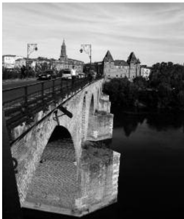
Fig. 22 - Montauban, Pont Vieux, vue des avant-becs côté amont. On observe le renforcement de leurs pointes par une chaîne en pierre de taille. Au-dessus, le garde-corps en fonte a été disposé sur l'élargissement des trottoirs en encorbellement.
