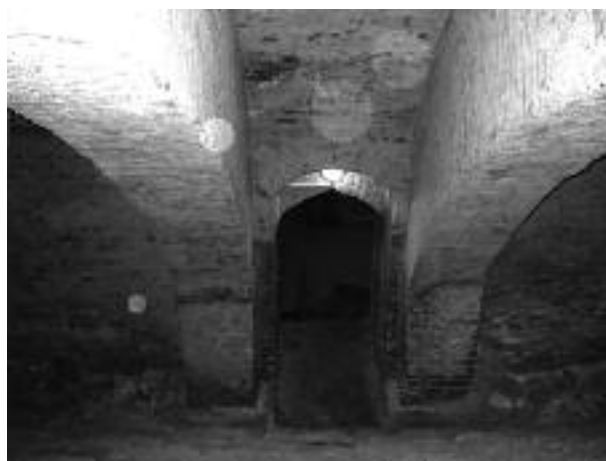
Fig. 21 - Montauban, Pont Vieux, vue des salles voûtées aménagées au-dessus de l'extrados des arches fluviales. La photographie montre la salle commandée par le niveau inférieur de la tour de ville. On observe au centre l'accès depuis cette tour.
