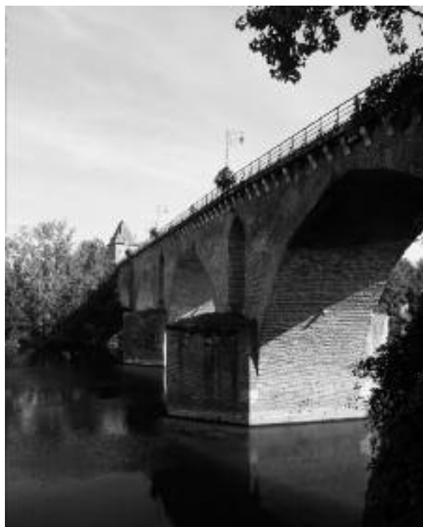
Fig. 23 - Montauban, Pont Vieux, vue des avant-becs côté aval depuis le faubourg de Villebourbon. Les arrière-becs n'ont pas été dotés de chaînes de pierre de taille sur toute leur hauteur.
