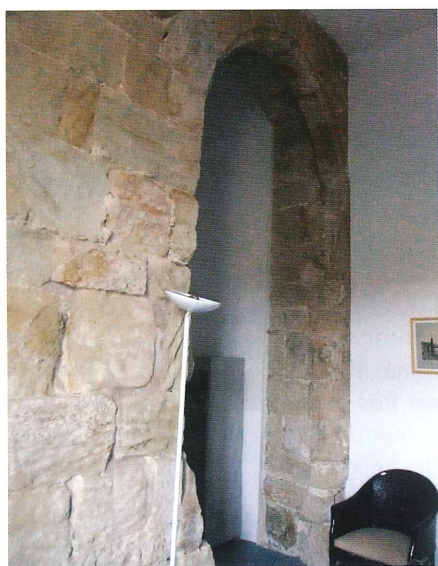
Fig. 6 - Le logis adossé au nord-ouest de l'infirmerie de l'abbaye, vue de la fenêtre gothique conservée dans une cellule de l'aile sud. Cette baie éclairait à l'ouest l'étage du logis adossé, cliché J.L. Rebière.
