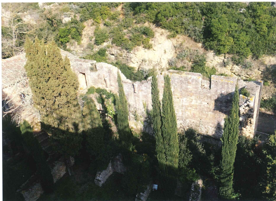
Fig. 2 - L'infirmerie de l'abbaye, vue de l'élévation ouest de l'infirmerie depuis la toiture du bras nord du transept, cliché J.L. Rebière.
